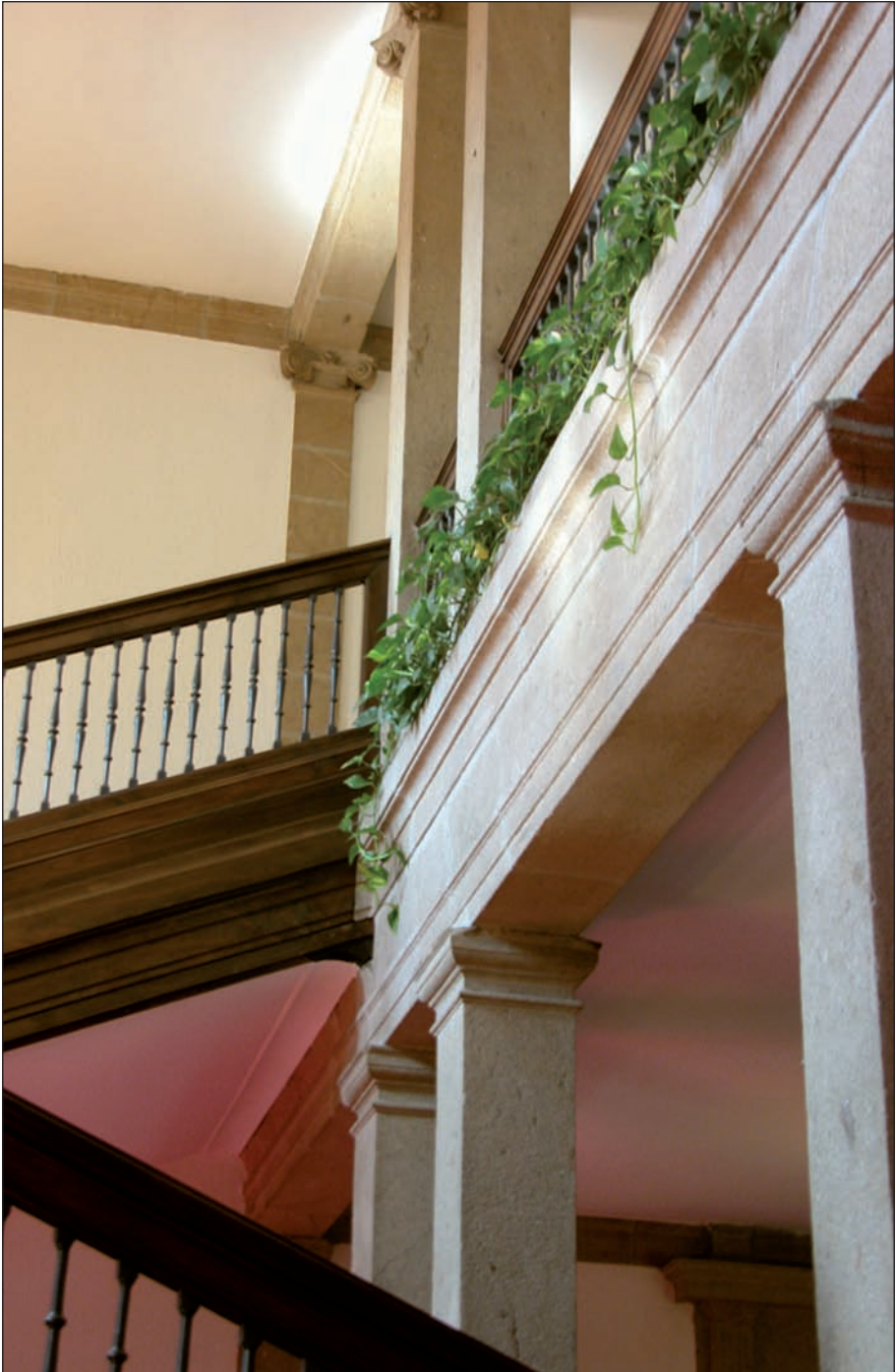
Escaleira principal do Pazo de Amarante, sede do Consello Consultivo de Galicia
